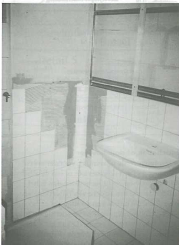
Voorzetwand waarop de afwerking wordt aangebracht.
